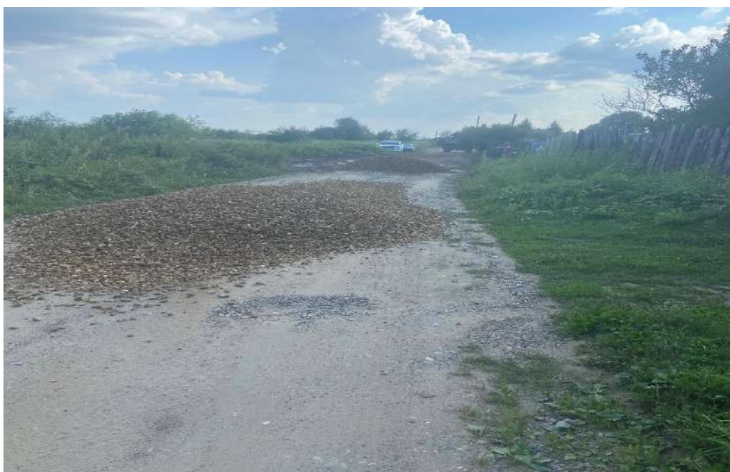
Выгрузка щебня фр.20-40 от участка №1424 в направлении уч.№1414
