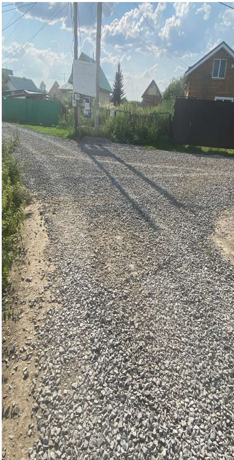
У – образный развилочный перекресток с примыканием уч.5203, 5011,5007 отсыпка щебнем фр.20-40
