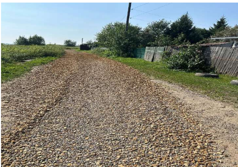
Отсыпка щебнем фр.20-40 уч.№2722 в направлении уч.№3108
