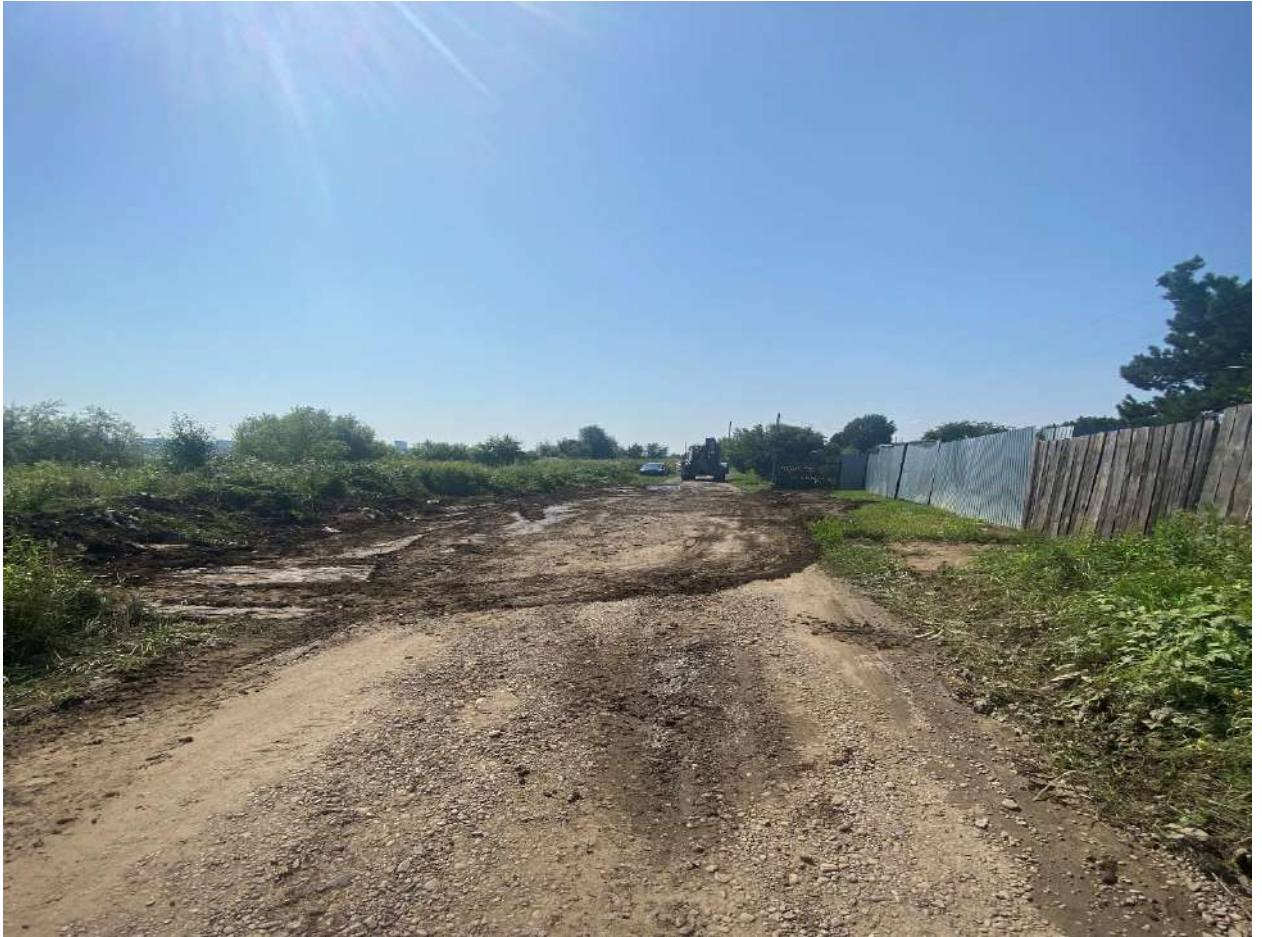
Отсыпка щебнем фр.20-40 уч.№1424 в направлении уч.№1414, а также срезка обочины от кустарника
