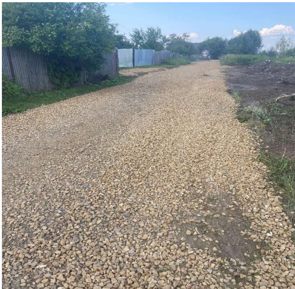
Отсыпка щебнем фр.20-40 уч.№1424 в направлении уч.№1414, а также срезка обочины от кустарника
